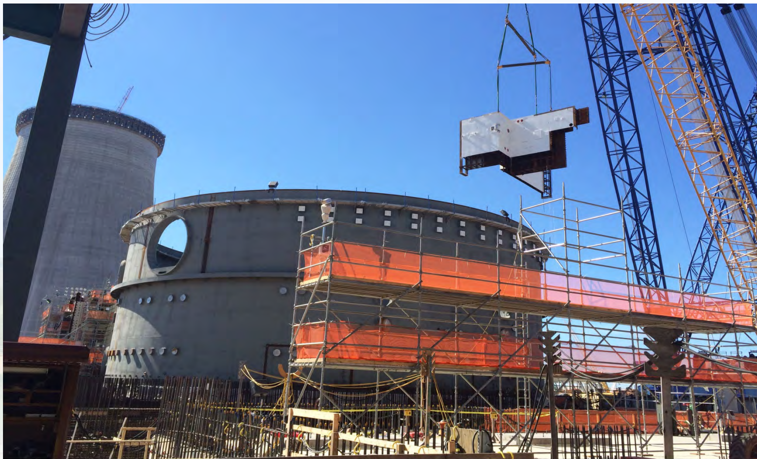
Vogtle Unit 3 CA05 module placement
