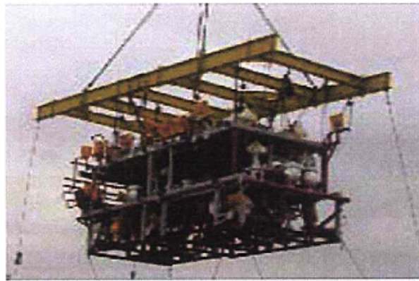
Condensate Demineralizer Module
